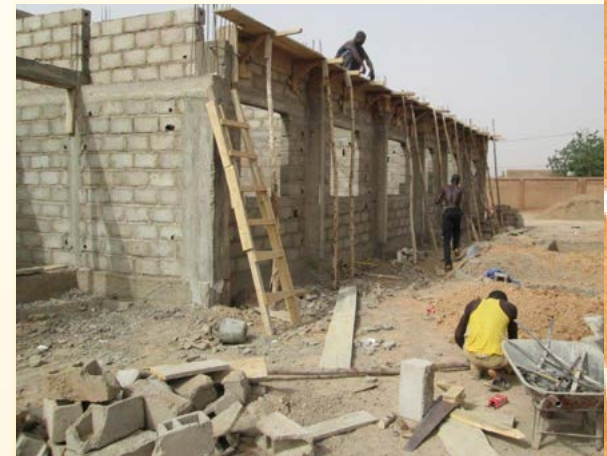
Die Bauarbeiten unserer CSPS (Dispensaire) sind in vollem Gange.
